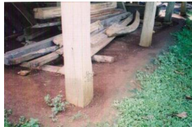
Gambar a Konstruksi Tiang yang di Tanam
