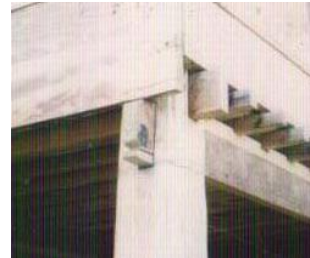
Gambar b Konstruksi Tiang, Karatang, dan Balok lantai (hulusu) tanpa Menggunakan patoddo
