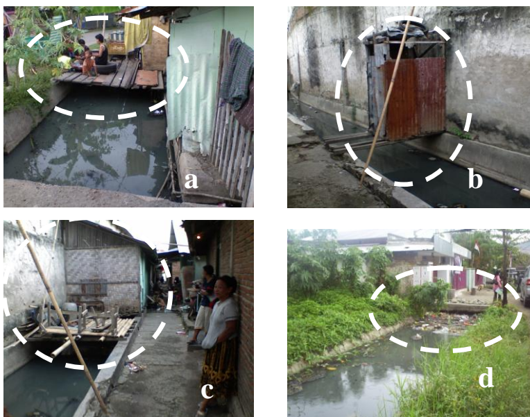
Gambar 3. Saluran ditutup untuk mendapatkan perluasan area beraktifitas yang tidak bisa tertampung lagi di dalam rumah/tempat melakukan aktifitas dapur (a), sebagai WC (b), sebagai dapur (tempat masak dan cuci piring (c). saluran drainase menggenang dan tersumbat akibat tumpukan sampah (d).
