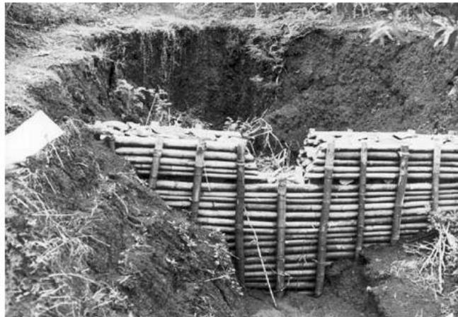
Gambar 4. Bangunan penahan longsor dari anyaman bambu untuk menahan longsor kategori ringan
