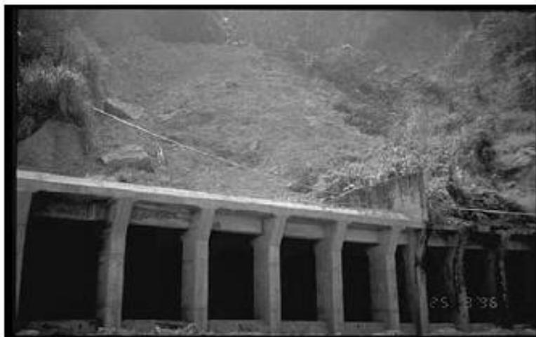
Gambar 5. Bangunan konstruksi beton penahan longsor kategori besar
