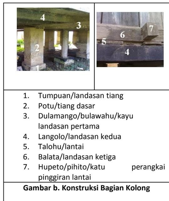
**Gambar 4. Makna Angka 7 di Bagian Struktur dan Konstruksi Badan Rumah (a), Struktur dan Konstruksi Kolong (b)**
