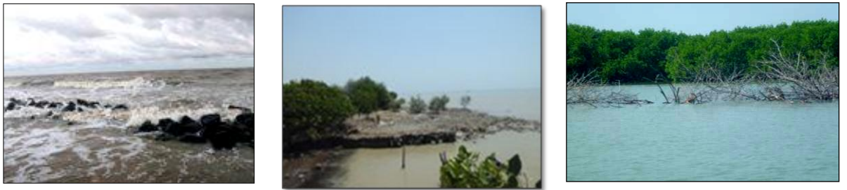
Gambar 2. Peredam gelombang, pantai dan vegetasi mangrove yang terabrasi
