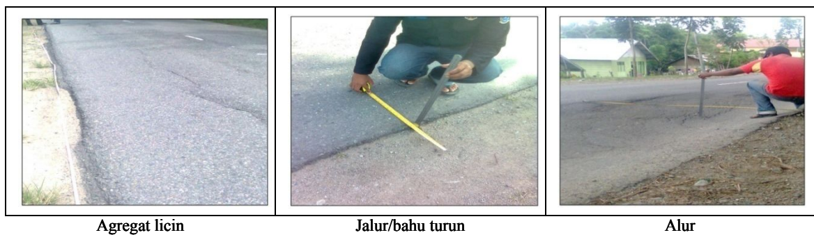
Gambar 3 Perbandingan Jenis Kerusakan.
