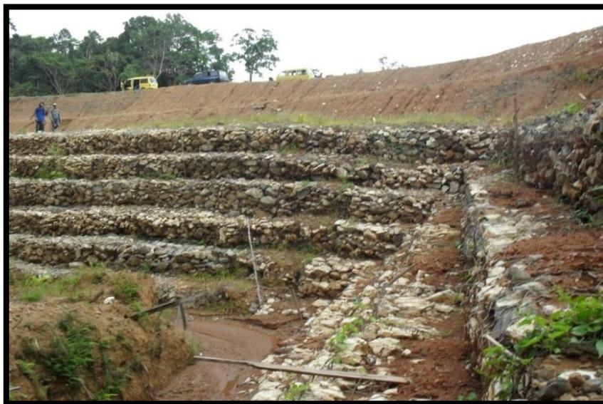
**Gambar 11. Analisa Geotek terhadap pencegahan jalan longsor yakni dengan jalan membuat bronjong (bertingkat)**
