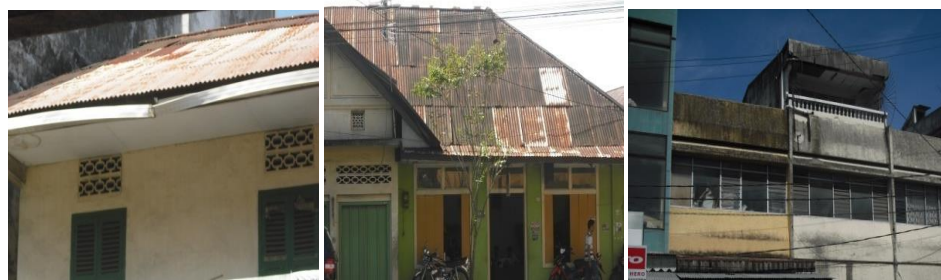
Gambar. Atap dari bahan seng dan beton Sumber : Hasil Survey,September 2010
