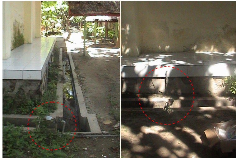
Gambar 4.20 Instalasi Air Bersih PDAM
