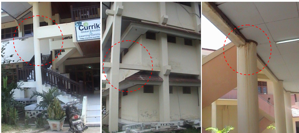
Gambar 4.13 Model Sambungan (Joint) Balok - Kolom
