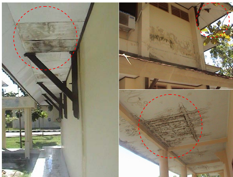
Gambar 4.41 Kebocoran Atap yang Merusak Plafond
