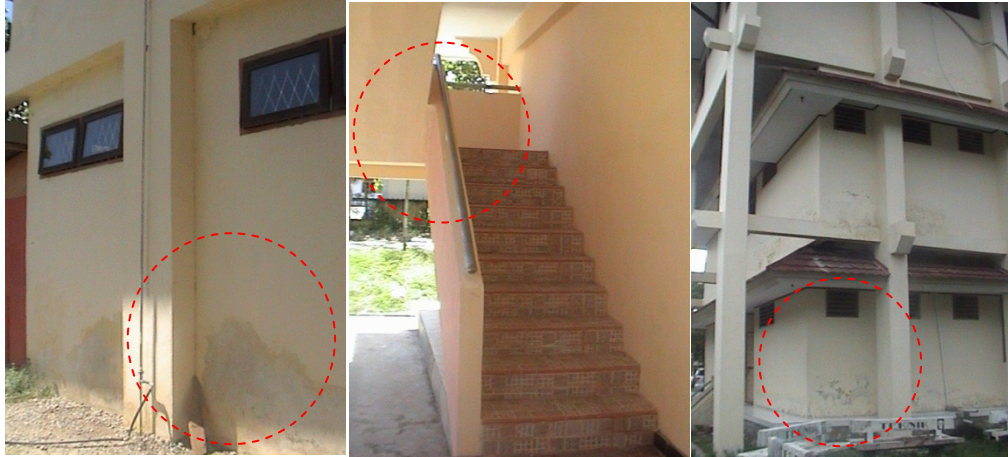
Gambar 4.4 Plesteran Dinding Yang Tidak Rata dan Cat Yang Terkelupas
