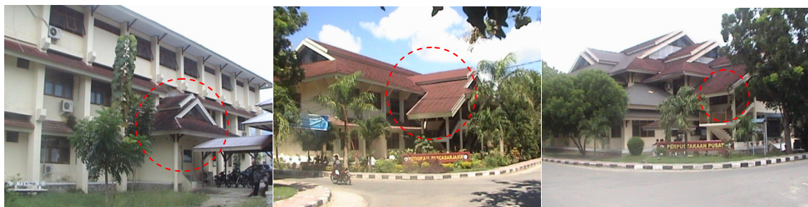
Gambar 4.40 Kerusakan Kerak Hitam pada Penutup Atap
