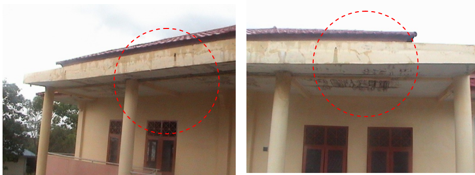
Gambar 4.36 Kerusakan Pelapis Dinding Luar oleh Faktor Air Hujan
