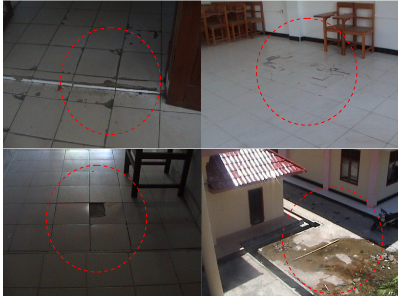
Gambar 4.6 Kondisi Pelapis Muka Lantai
