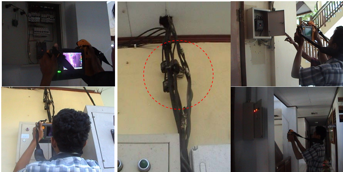
Gambar 4.25 Proses Pemeriksaan Instalasi Listrik Dengan Alat Infra Red
