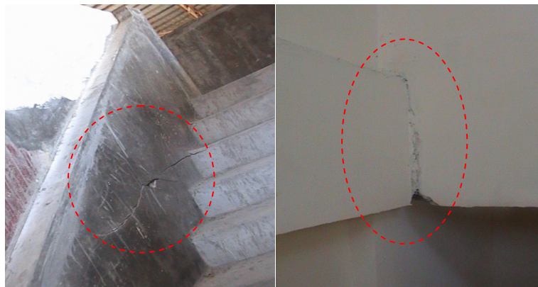
Gambar 4.45 Kerusakan Retak pada Tangga dan Pertemuan Antar Balok
