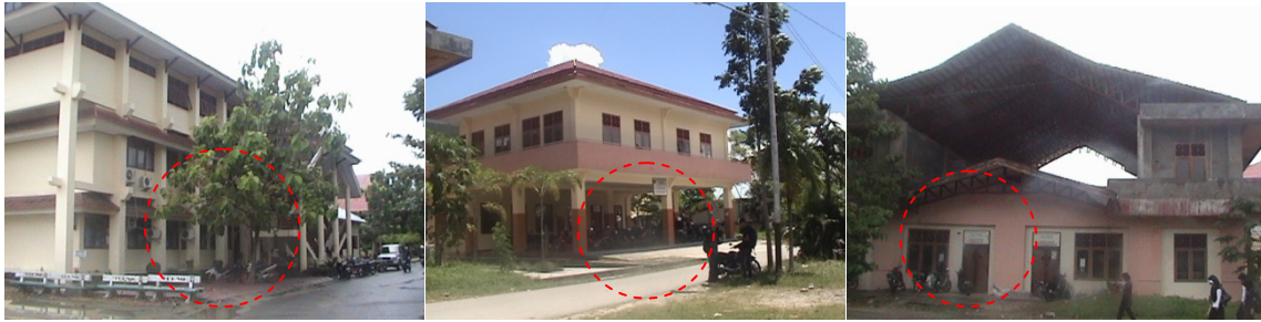
Gambar 4.31 Kondisi Pemanfaatan Area Parkir
