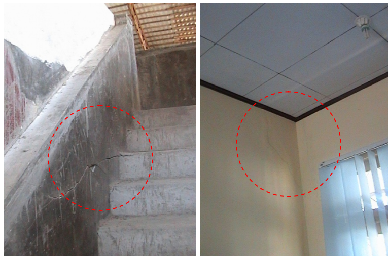
Gambar 4.38 Kerusakan Retak Pada Plesteran Dinding
