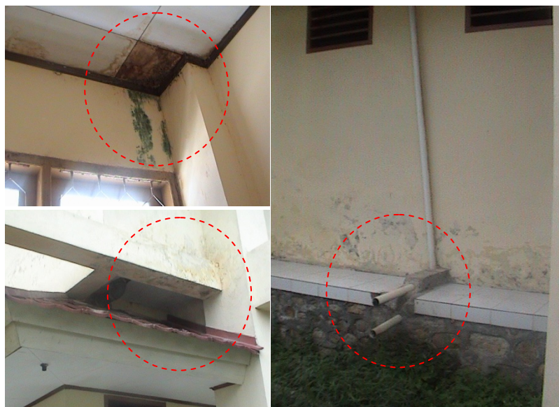
Gambar 4.22 Sistem Instalasi Air Kotor Yang Tidak Sesuai Standar
