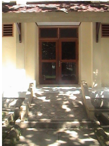
Gambar 4.30 Kondisi Penggunaan Ramp Pada Bangunan Gedung
