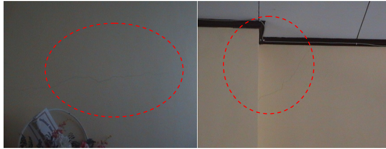
Gambar 4.43 Kerusakan Retak Pada Pasangan Dinding
