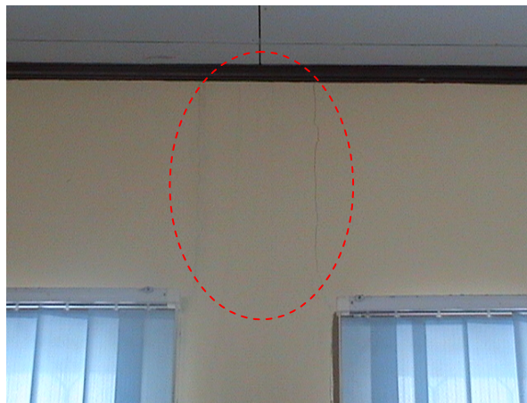
Gambar 4.44 Kerusakan Retak Memanjang Antara Kolom dan Dinding
