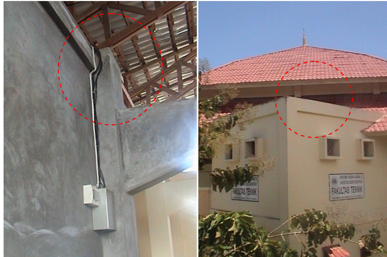
Gambar 4.16 Posisi Sloof Atap Pada Bangunan Gedung
