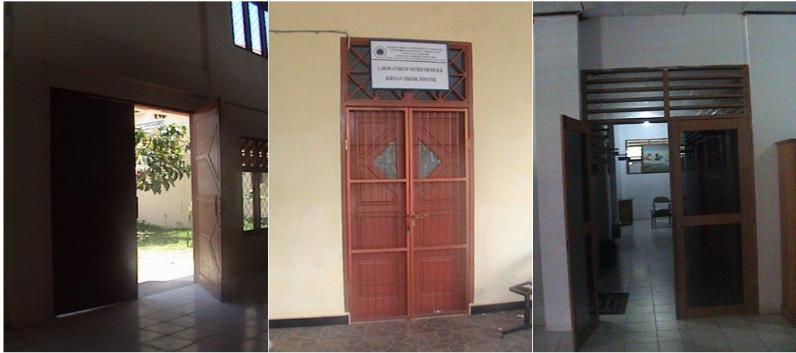
Gambar 4.34 Kondisi Pintu Pada Bangunan Gedung
