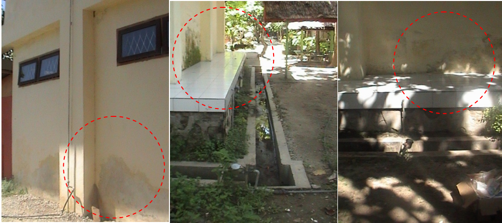
Gambar 4.35 Kerusakan Pelapis Dinding Luar oleh Rembesan dari Tanah
