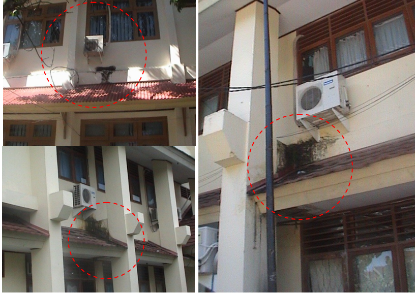
Gambar 4.37 Kerusakan Pelapis Dinding Luar oleh Faktor Kerusakan Utilitas
