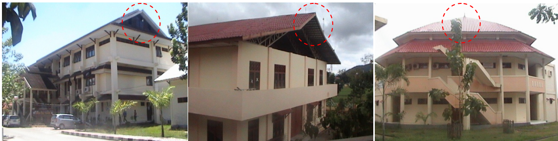
Gambar 4.27 Penempatan Sistem Penangkal Petir Franklin Rod
