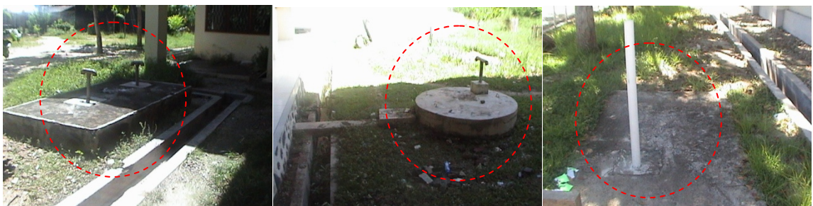
Gambar 4.24 Kondisi Septictank Pada Bangunan
