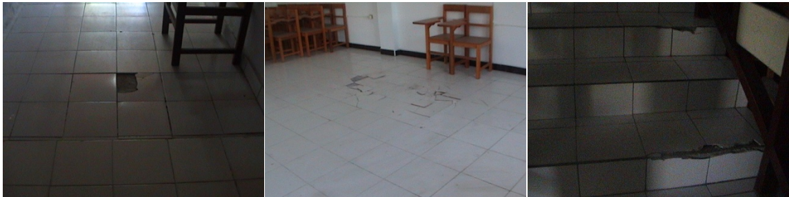
Gambar 4.39 Kerusakan Retak Pelapis Muka Lantai
