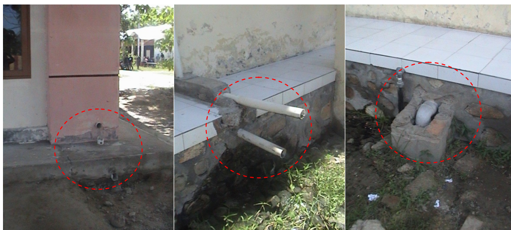
Gambar 4.46 Kondisi Instalasi Pemipaan Pada Bangunan Gedung
