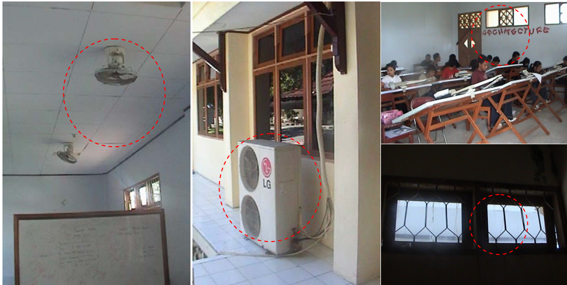
Gambar 4.26 Pemanfaatan Penghawaan Alami dan Buatan Pada Ruang
