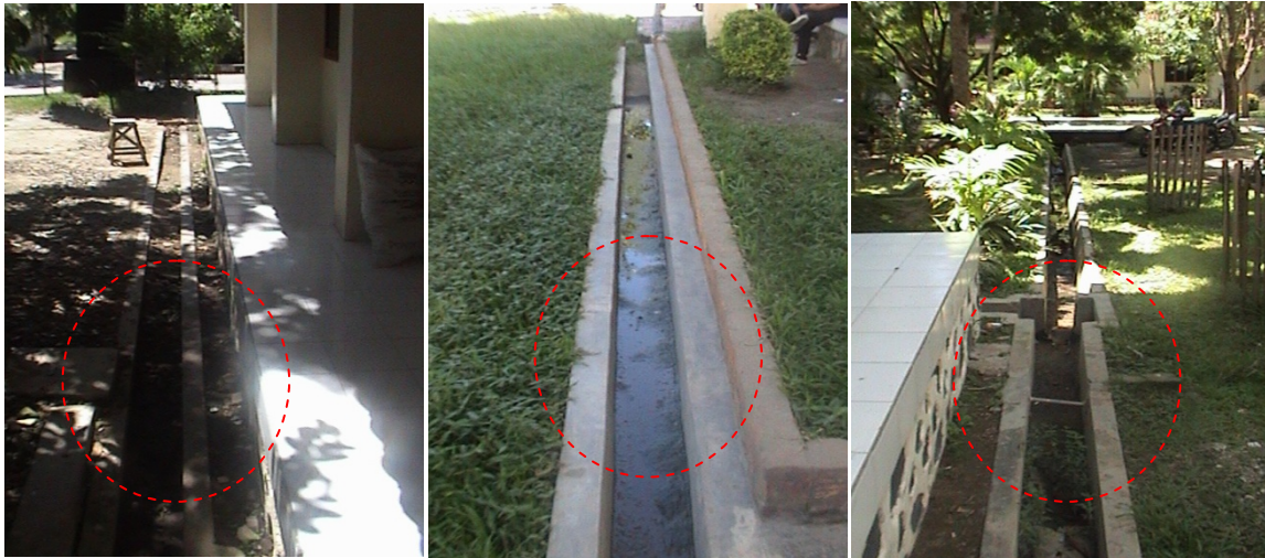
Gambar 4.23 Kondisi Saluran Air Luar Bangunan
