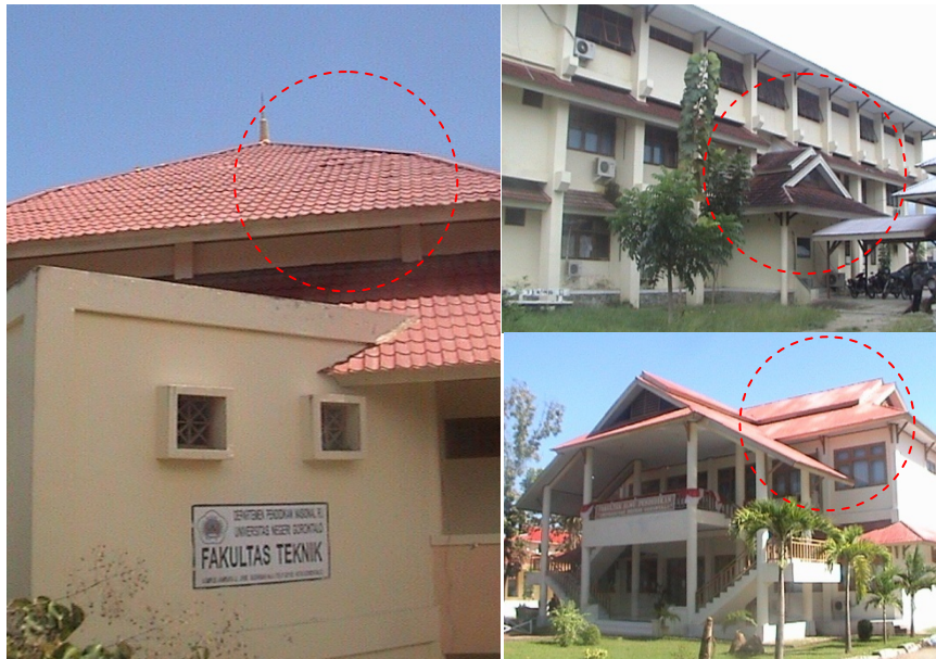
Gamba 4.8 Kondisi Penurunan Kualitas Pada Penutup Atap
