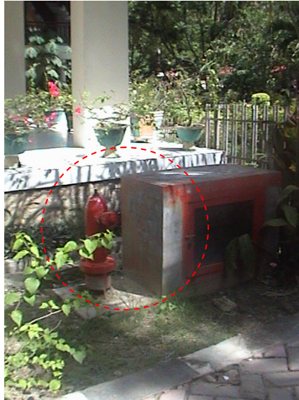
Gambar 4.18 Fasilitas Pencegahan Kebakaran Hidrant Air
