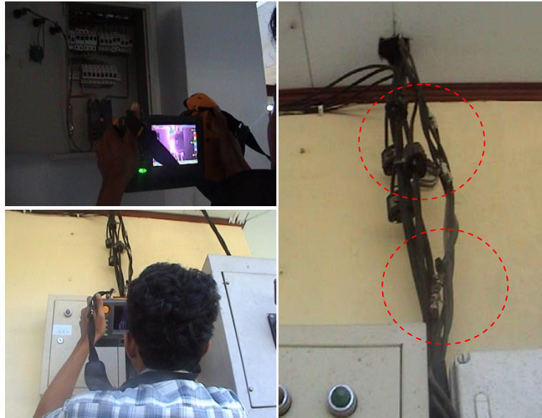
Gambar 4.47 Kondisi Instalasi Kabel Listrik yang Rusak
