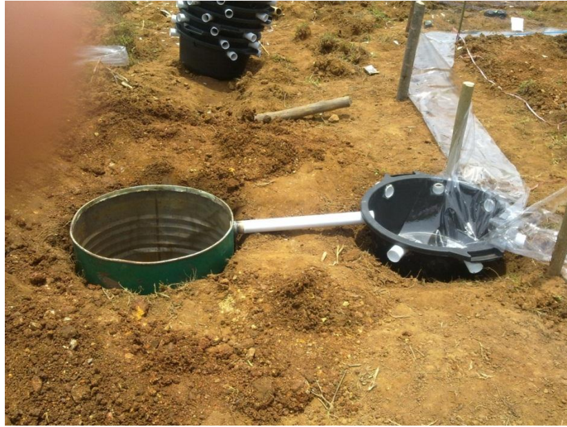
Gambar 5. Pemasangan penampung aliran permukaan dan sedimen
