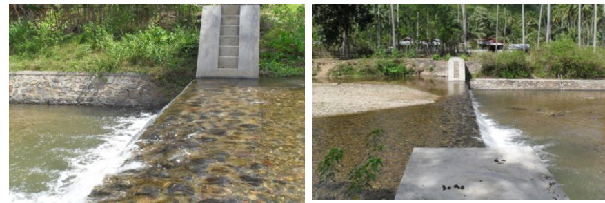
GAMBAR CHEKDAM SUNGAI BIONGA
