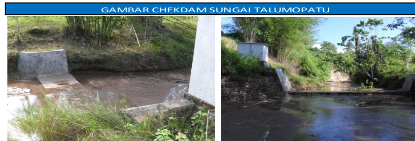
GAMBAR CHEKDAM SUNGAI TALUMOPATU
