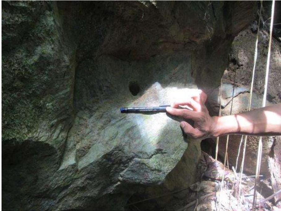
Foto 16 Kenampakan singkapan andesit yang terdapat terowongan Berg yang memperlihatkan bekas bor sebagai tempat memasukkan bahan peledak
