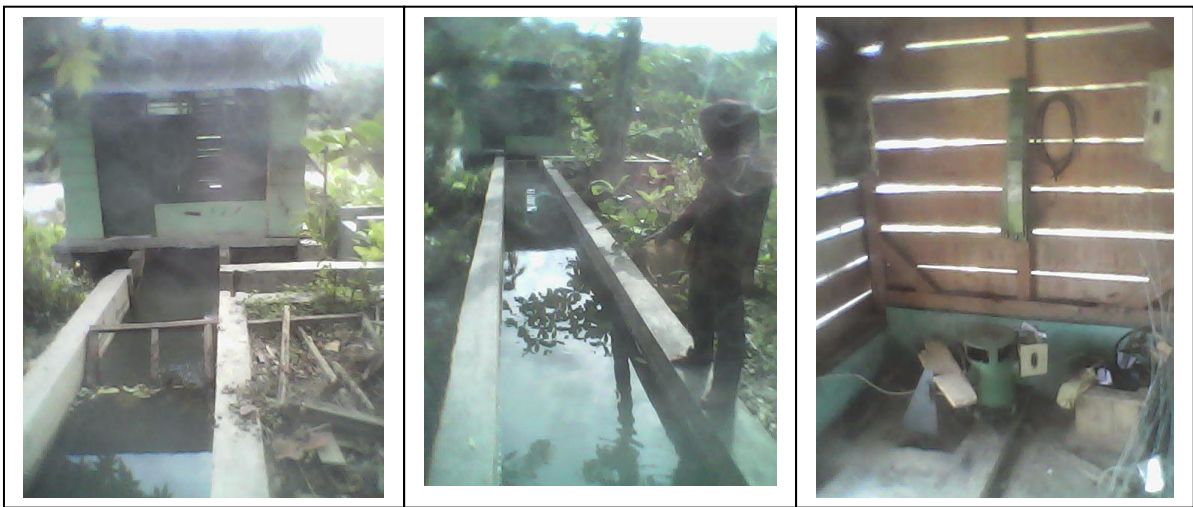
Gambar 4. Fasilitas Rumah Turbin, Mesin Turbin dan Bak Penenang TTG PLTMH di Desa Tulabolo yang Terbengkalai tidak Terawat
