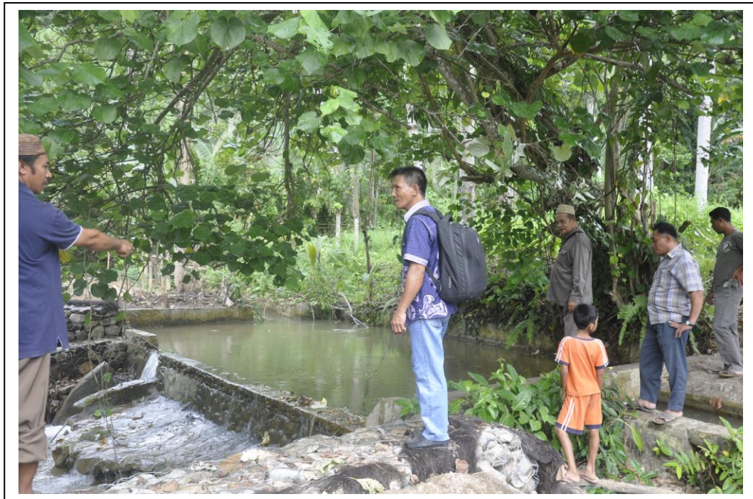
Gambar 2. Salah satu Fasilitas Teknologi Tepat Guna Pembangkit Listrik Tenaga Mikro Hidro (Bak Penenang) di Desa Tulabolo yang Rusak
