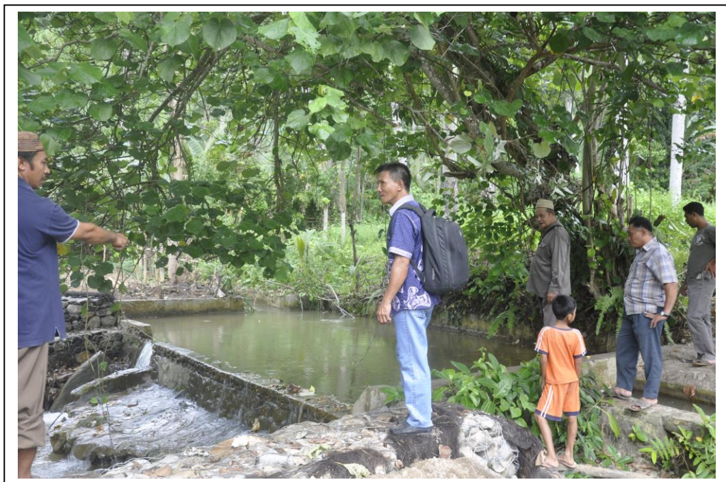
Gambar 5.4 Salah satu Fasilitas Teknologi Tepat Guna Pembangkit Listrik Tenaga Mikro Hidro (Bak Penenang) di Desa Tulabolo yang Rusak
