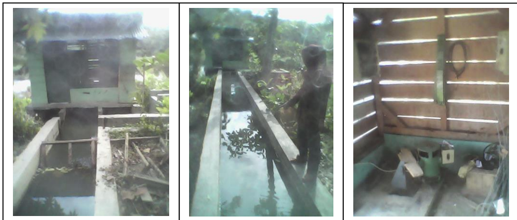
Gambar 5.6 Fasilitas Rumah Turbin, Mesin Turbin dan Bak Penenang TTG PLTMH di Desa Tulabolo yang Terbengkalai tidak Terawat
