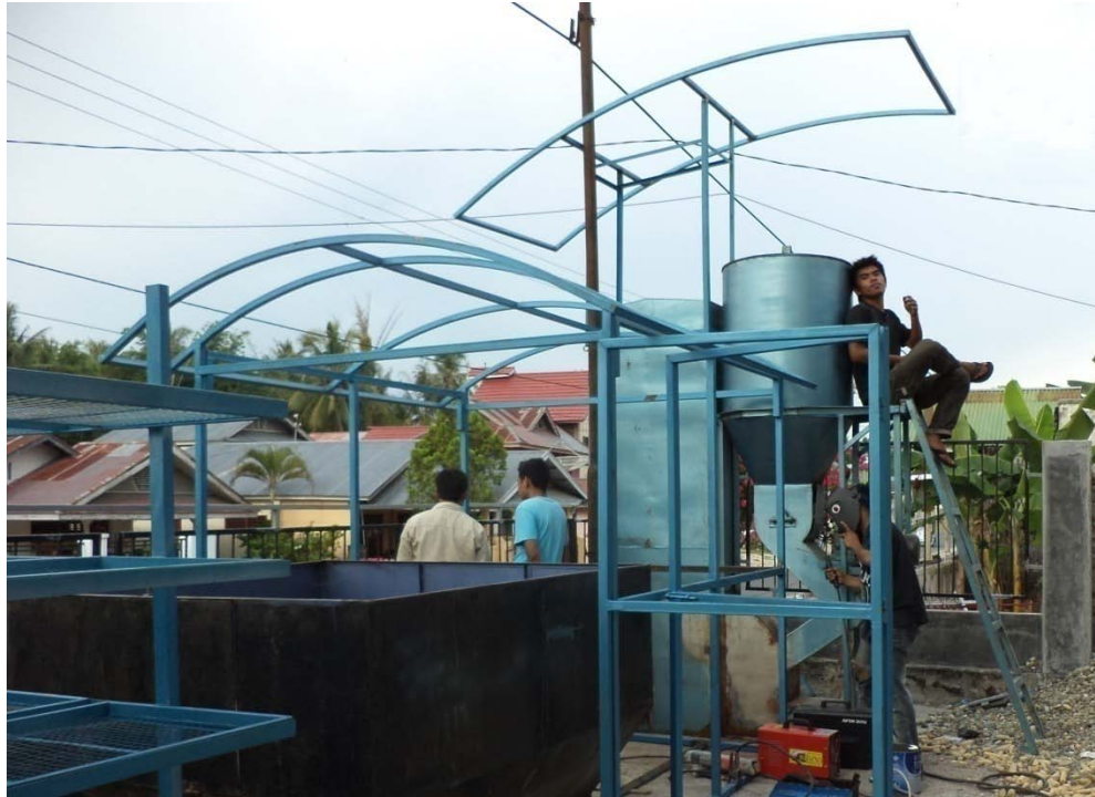
Gambar 7. Instalasi Struktur Pengering ERK
