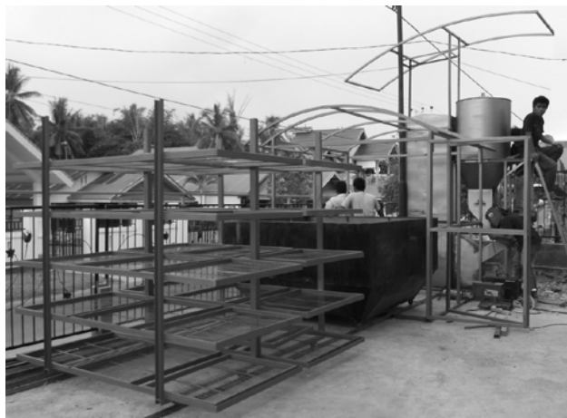
Gambar 2. Instalasi unit sistem pengeringan
