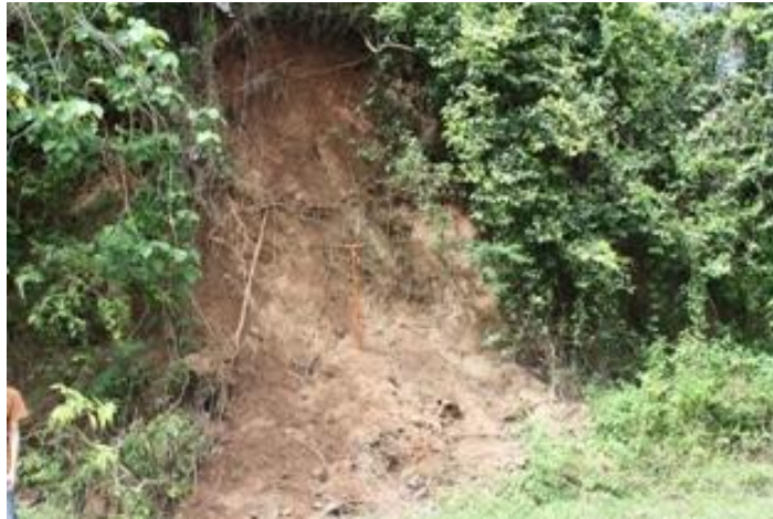
Gambar 5.16 Kondisi Longsor di Desa Labanu Kecamatan Tibawa Kabupaten Gorontalo
