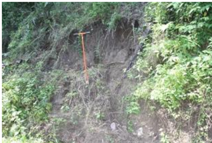
Gambar 5.19 Kondisi Longsor pada Desa Molalahu Kecamatan Pulubala Kabupaten Gorontalo
