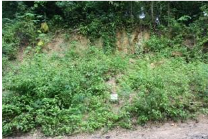
Gambar 5.20 Kondisi Longsor pada Desa Isimu Utara Kecamatan Tibawa Kabupaten Gorontalo
