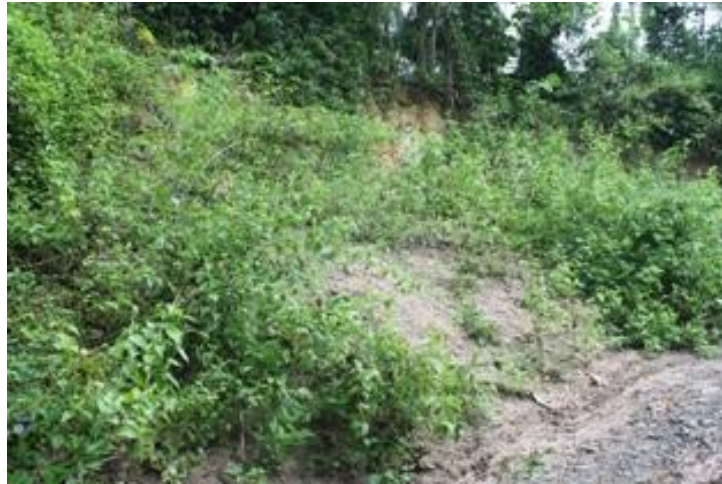
Gambar 5.22 Kondisi Longsoran di Desa Isimu Utara Kecamatan Tibawa Kabupaten Gorontalo
