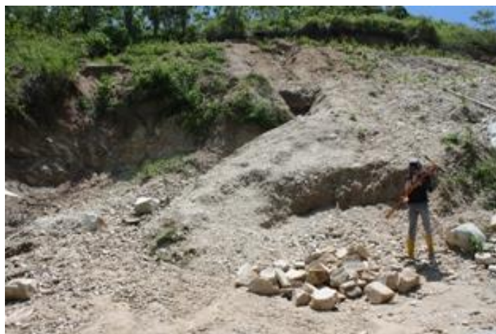
Gambar 5.17 Kondisi Longsor di Desa Toyidito Kecamatan Pulubala Kabupaten Gorontalo
