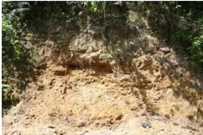
Gambar 5.18 Kondisi Longsor di Desa Molalahu Kecamatan Pulubala Kabupaten Gorontalo
