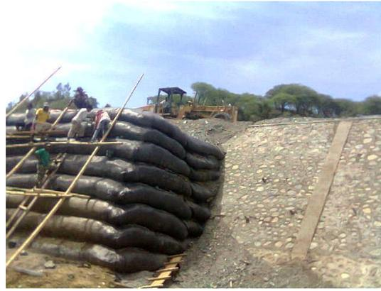
**Gambar 14.** Kombinasi geotekstil dan dinding penahan tanah (Foto dok. Achmad)
