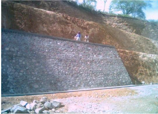
**Gambar 9.** Penanganan dengan dinding penahan tanah (Foto dok. Achmad)
