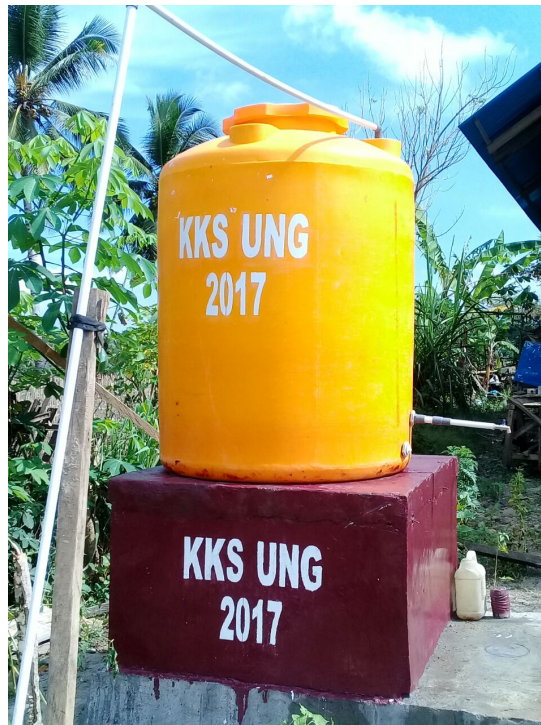
Gambar 9. Tangki Air Jaringan Distribusi Air Bersih
