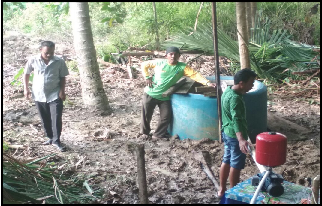
Gambar 5. Pemasangan Pompa (Jet Pump)
