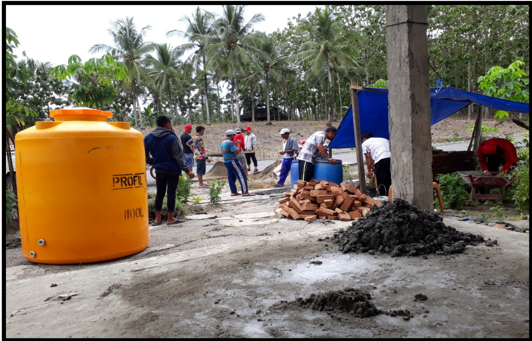
Gambar 7. Pembuatan Pondasi / Dudukan Tangki Air
