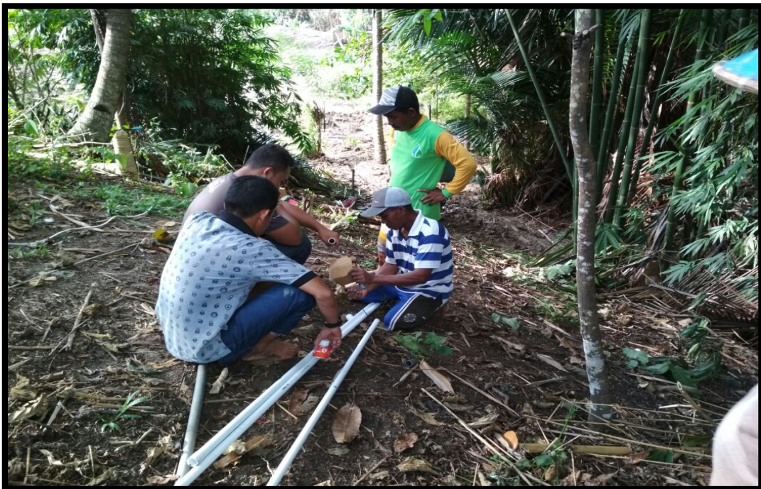
Gambar.4 Pemasangan Pipa dari Sumber Air
