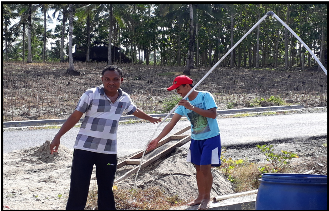
Gambar 6. Pemasangan Jaringan Pipa
