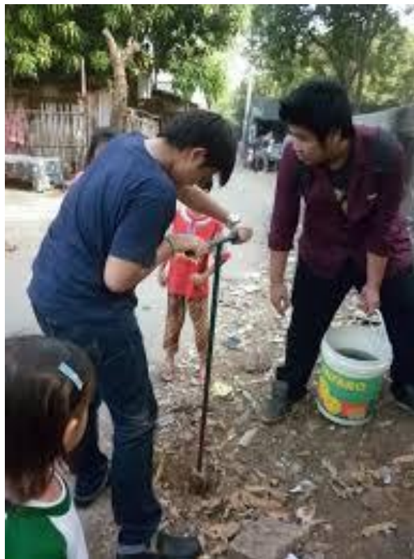
Gambar 3. Pembuatan biopori oleh mahasiswa KKN RM
