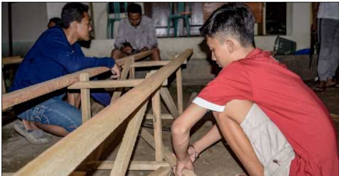
Gambar 5.11 Proses pembuatan gapura desa
