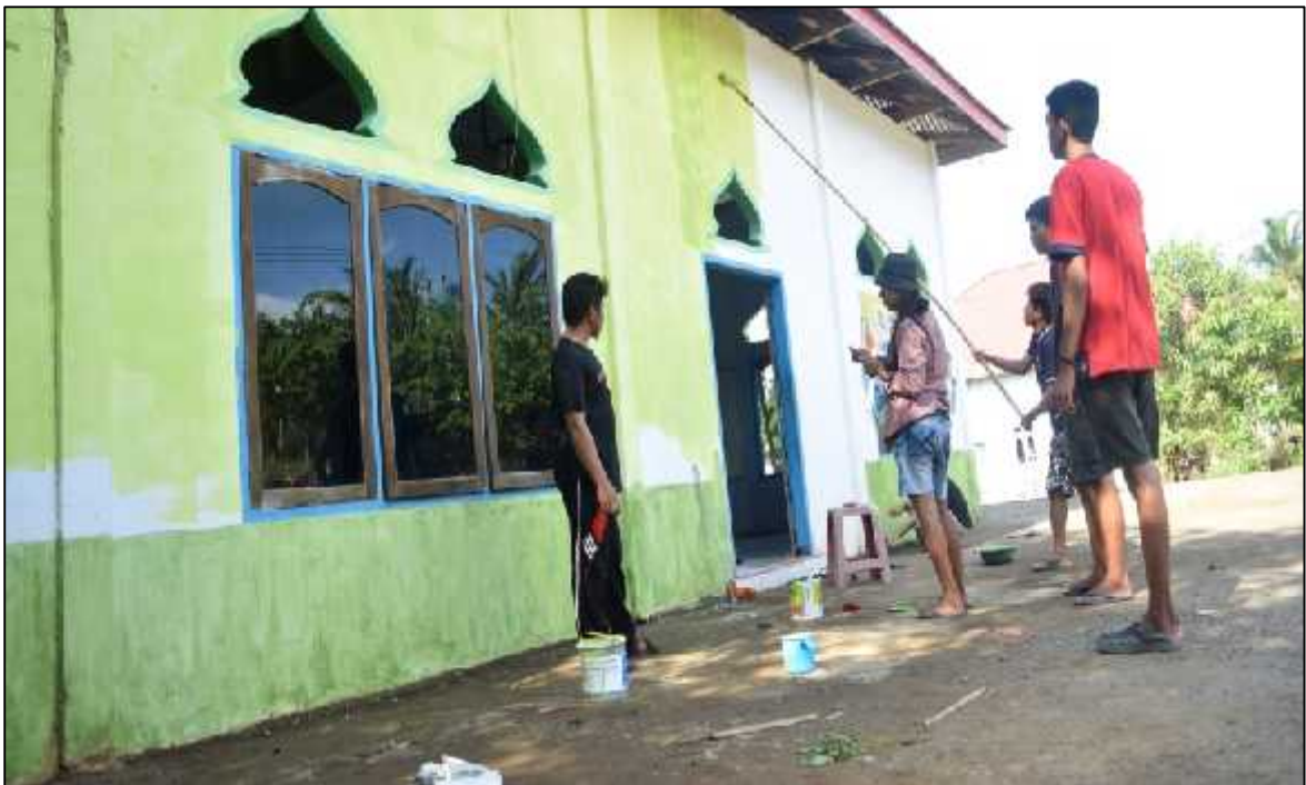
Gambar 5.9 pengecatan masjid Ar-rahman desa Tutuwoto
