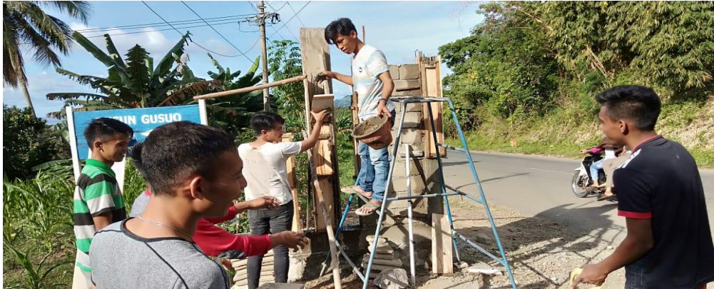
Gambar 2.6 Pembangunan tapal batas desa Kotajin Utara-Oluhuta
