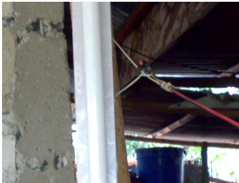
Gambar 3. Sambungan Kabel Secara Sembrono
