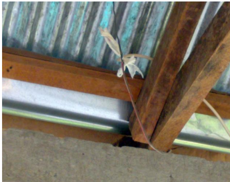
Gambar 2. Sambungan Kabel Menggunakan Isolasi Plastik
