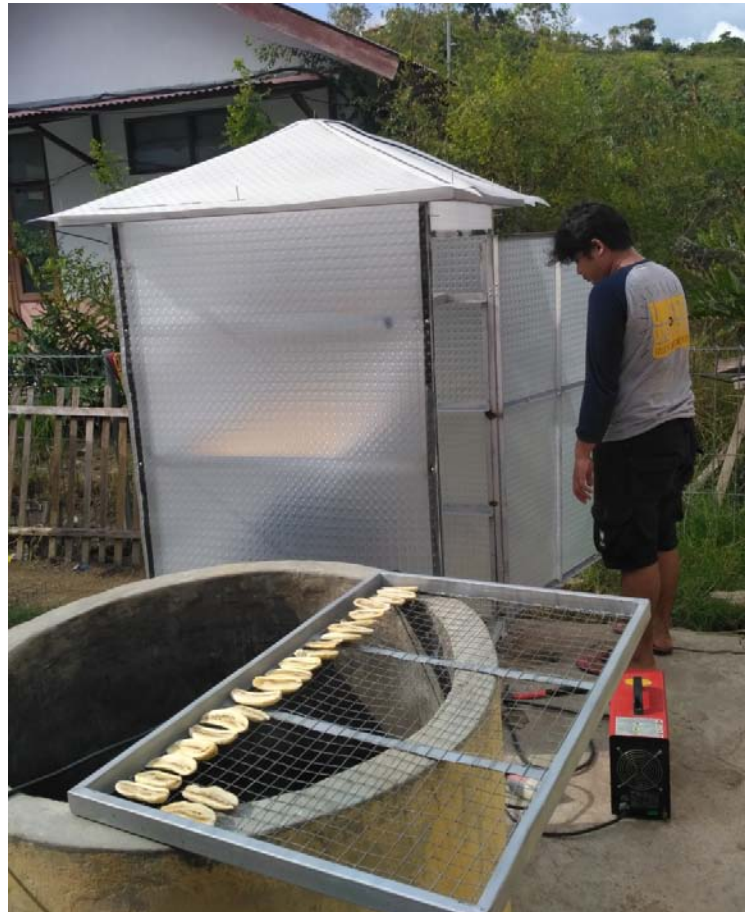
Gambar 8. Pengelasan Konstruksi Alat Penngering oleh Tenaga Kerja Bengkel
