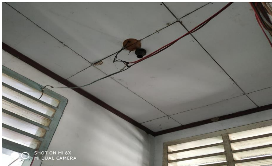
Gambar.3 Sambungan Kabel yang tidak sesuai Standar SNI
