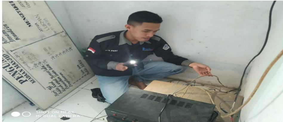
Gambar 5. Perbaiki Kabel untuk Sound System Mesjid Ramsis
