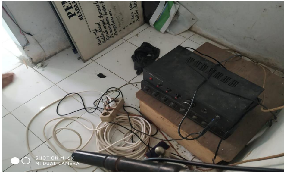
Gambar.5 Alat Sound System Mesjid Ramsis Yang Rusak
