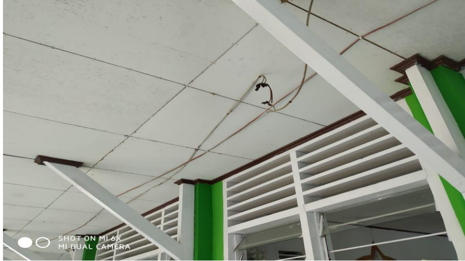
Gambar 4. Sambungan Kabel Yang Tidak Menggunakan Isolasi yang Sebenarnya
