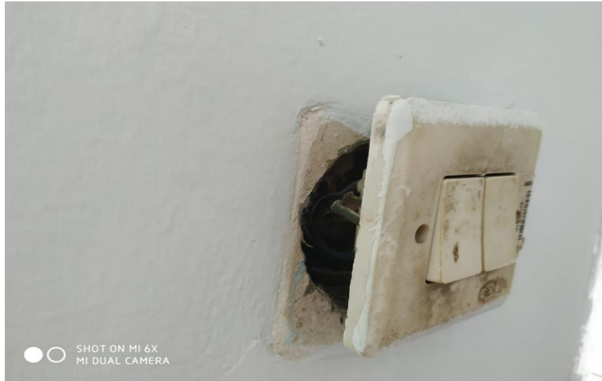
Gambar. 2 Saklar Lampu Yang Terbuka
