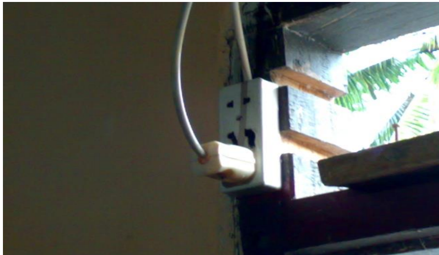
Gambar 1. Kotak Kontak yang tidak sesuai Standar SNI
