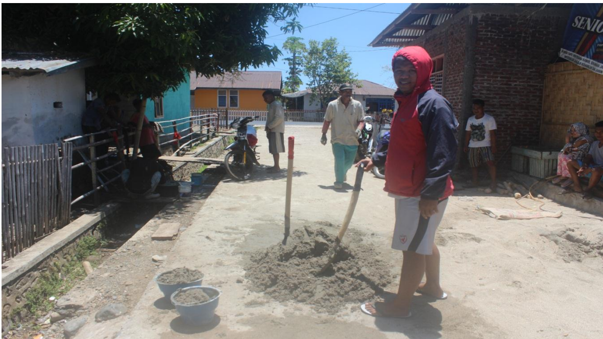
Gambar 4. Tahap Pengerjaan Fisik Perbaikan Masjid Desa
