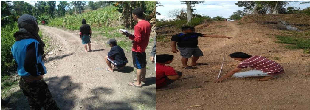
Gambar 2. Proses Pengukuran Ruas Jalan Desa Foto: Mahasiswa KKS-Pengabdian, 2016
