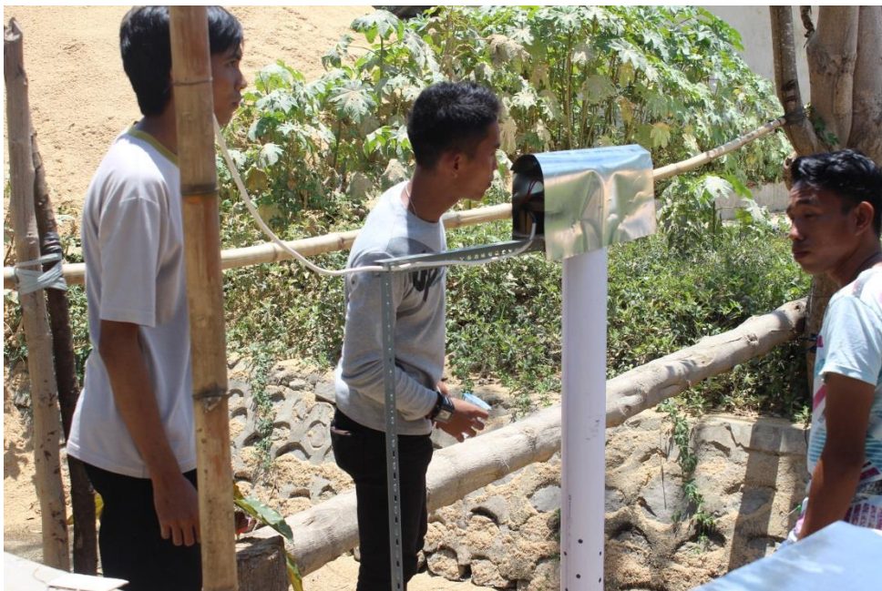
Gambar 5.9. Pemasangan alat di Dusun Pilomalula
