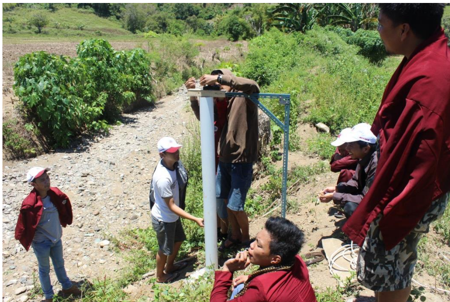
Gambar 5.7. Pemasangan alat di Dusun Tuhiango
