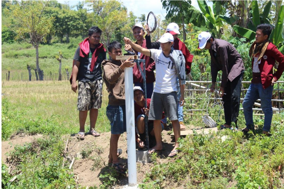
Gambar 5.6. Pemasangan alat di Dusun Tuhiango
