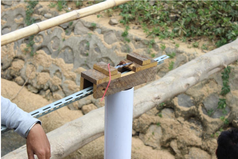
Gambar 5.8. Pemasangan alat di Dusun Pilomalula
