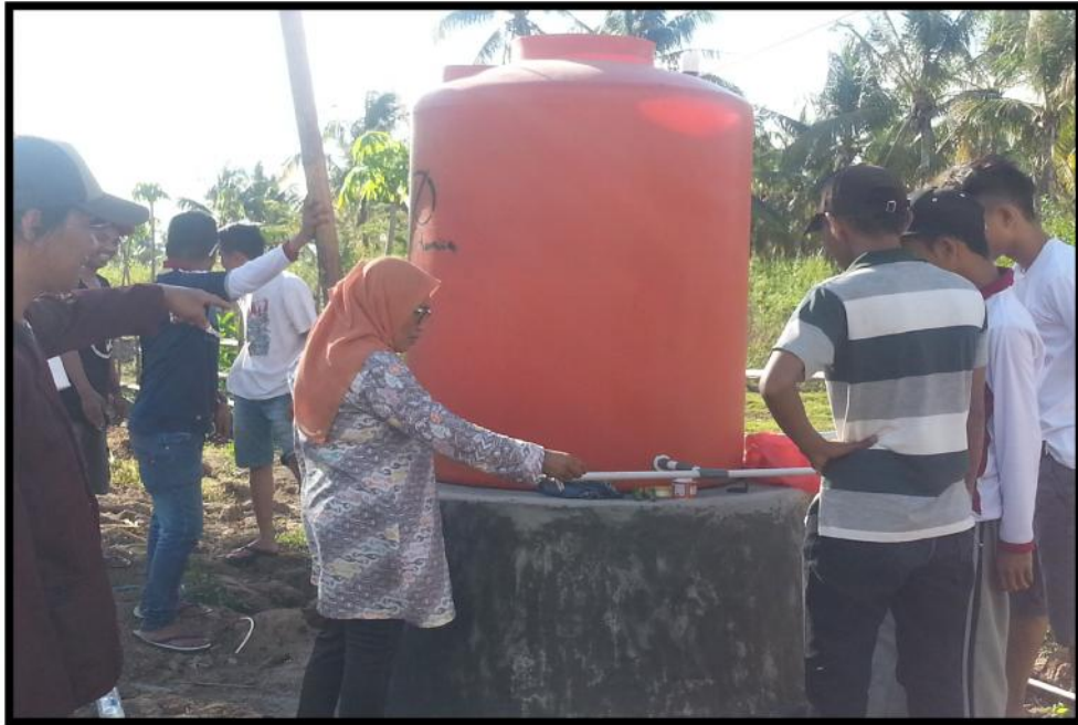
Gambar 5.9 Pemasangan Tangki dan Kran air
