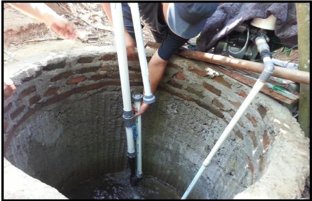
Gambar 5.4 Pemasangan Pipa dari Sumber Air
