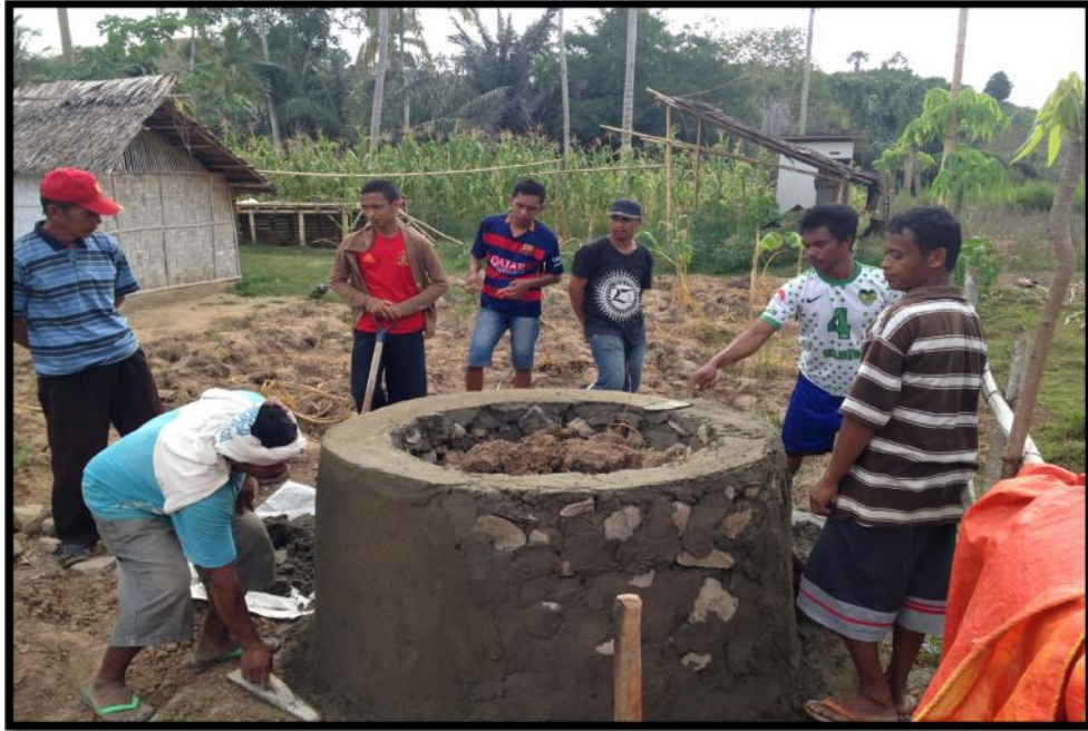
Gambar 5.8 Pembuatan Pondasi / Dudukan Tangki Air
