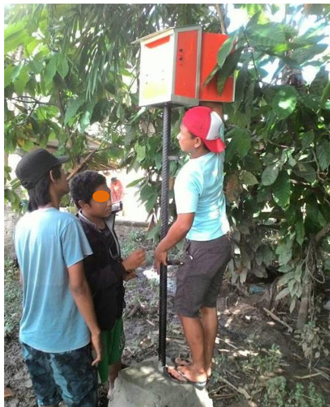
Gambar 5.5. Pemasangan alat di Dusun Taipangi
