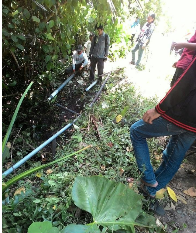
Gambar 5.12. Perbaikan pipa air bersih
