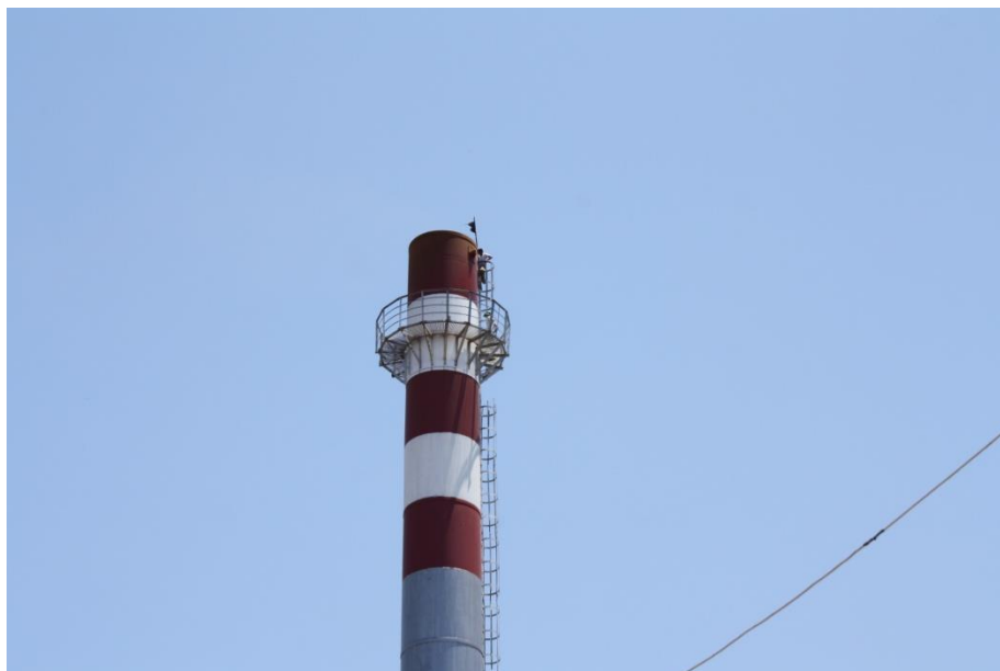
Pengambilan Sampel Gas Emisi Cerobong
