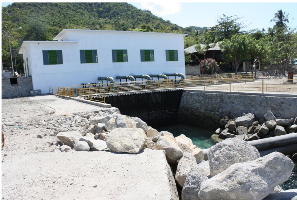
Rumah Pompa untuk inlet air pendingin PLTU Molotabu
