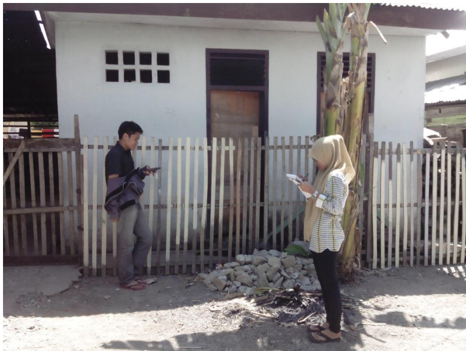
Gambar 5.9. Kondisi MCK yang sudah tidak bisa digunakan di Jl. Brigjen Piola Isa
