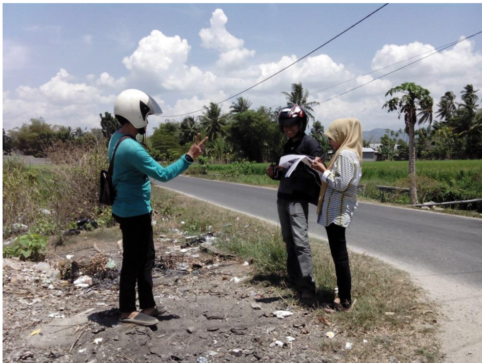
Gambar 5.7. Kondisi Jl. Taman Hiburan II (sisi kiri tidak memiliki saluran drainase)
