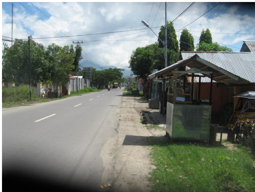
Gambar 5.5. Kondisi Jl. Brigjen Piola Isa (sisi kanan tidak memiliki saluran drainase)
