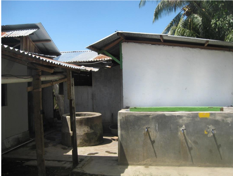
Gambar 5.8. Kondisi MCK di Jl. Taman Hiburan I
