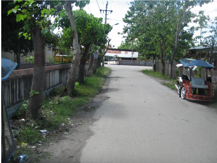
Gambar 5.4. Kondisi simpang tiga Jl. K.H. Adam Zakaria - Jl. Taman Hiburan I yang tidak memiliki saluran drainase
