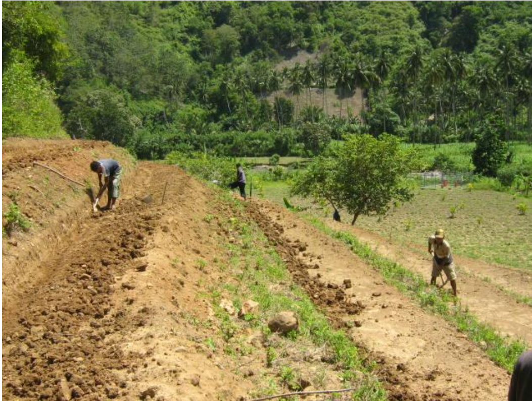
Gambar 12. Proses Pembuatan Teras Sering pada Lahan Miring (sumber: Foto Ilahude et al. 2007)
