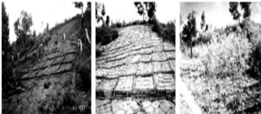
Gambar 4.12 Rangkaian Pembuatan dan Hasil Dari Teras Kotak pada Lahan Kritis
