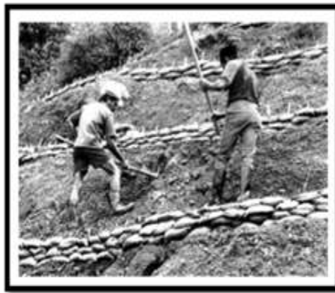
Gambar 4.13 Bangunan Teras Karung
