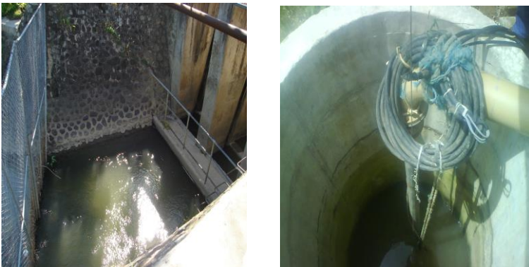
Gambar 18. Kondisi Intake Kabila dan Intake Bulotadaa
