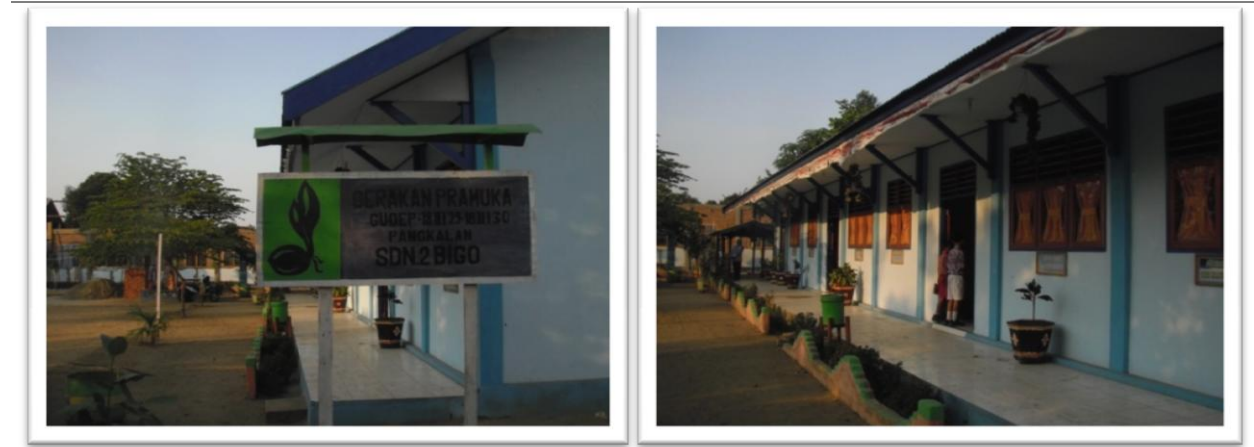
Gambar 12. Salah satu bangunan sekolah yang terdapat di Kabupaten Bolaang Mongondow Utara
