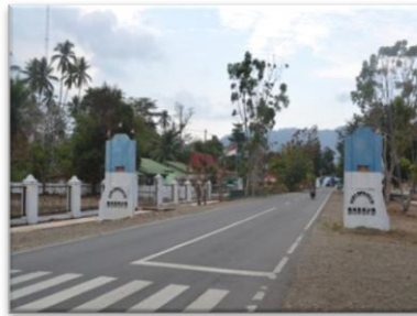
Perawatan Jalan Utama
