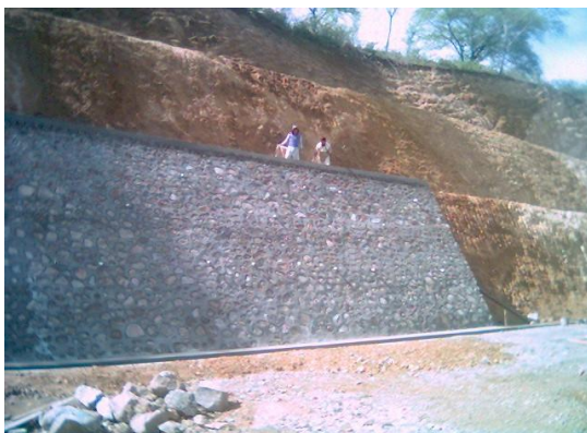
Gambar 6. Penanganan dengan dinding penahan tanah (Foto dok. Achmad).
