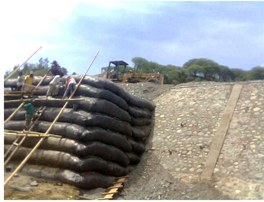
Gambar 11. Kombinasi geotekstil dan dinding penahan tanah (Foto dok. Achmad)
