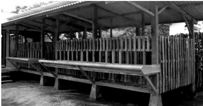
Model kandang panggung dibuat untuk mempermudah pengelolaan limbah kotoran dan urin kambing.
