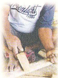
Gambar 1.16 Bambu Dibuat Lidah
