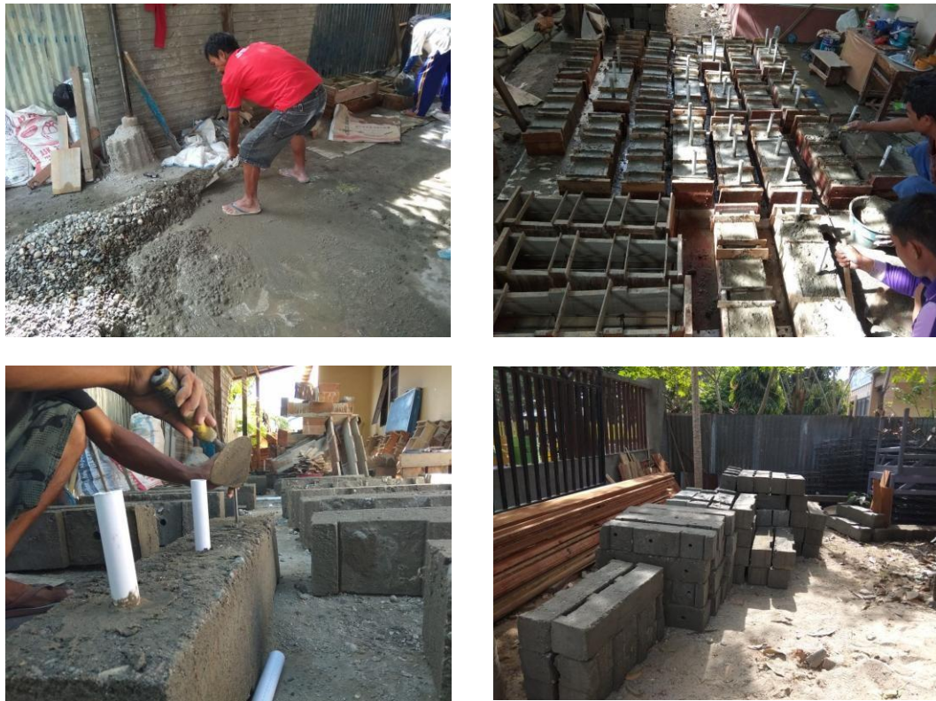
Gambar 14. Proses Pembuatan Media Nursery: (1 & 2) Membentuk besi sebagai rangka beton; (3 & 4) Mencetak beton dan mengisi ke dalam mall cetakan; (5 & 6) Media Nursery yang telah jadi
