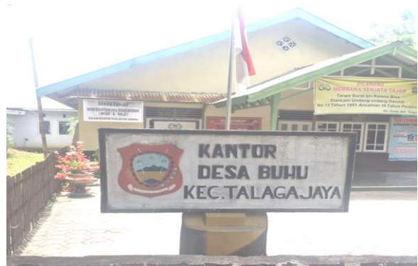
Gambar 2. Kantor Desa Buhu Kab. Gorontalo
