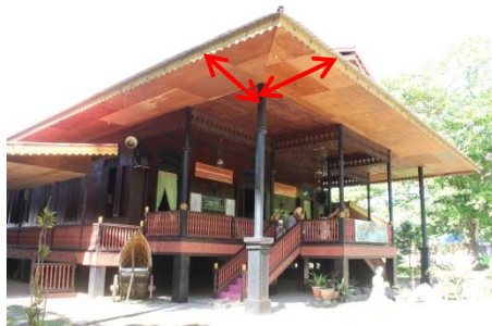
Gambar 11. Teritisan atap lebar pada Bantayo Pobo'ide. (16 April 2015)
