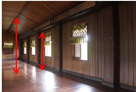
Gambar 10. Perbandingan tinggi plafon terhadap tinggi dinding keliling bangunan di Dulohupa. (19 Mei 2015)
