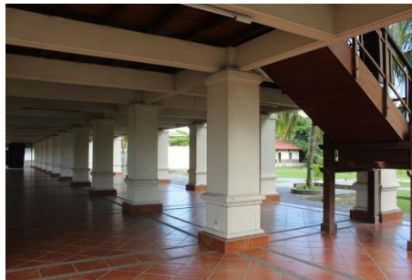
Gambar 1. Kolong Dulohupa, ruang terbuka tanpa dinding. (foto diambil pada tanggal 19 Mei 2015)
