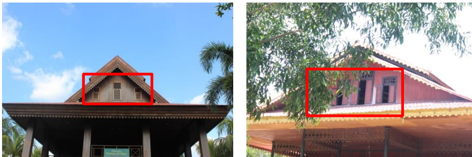
Gambar 7. Ventilasi atap pada Dulohupa (kiri, 19 Mei 2015) dan Bantayo Pobo'ide.(kanan, 16 April 2015)
