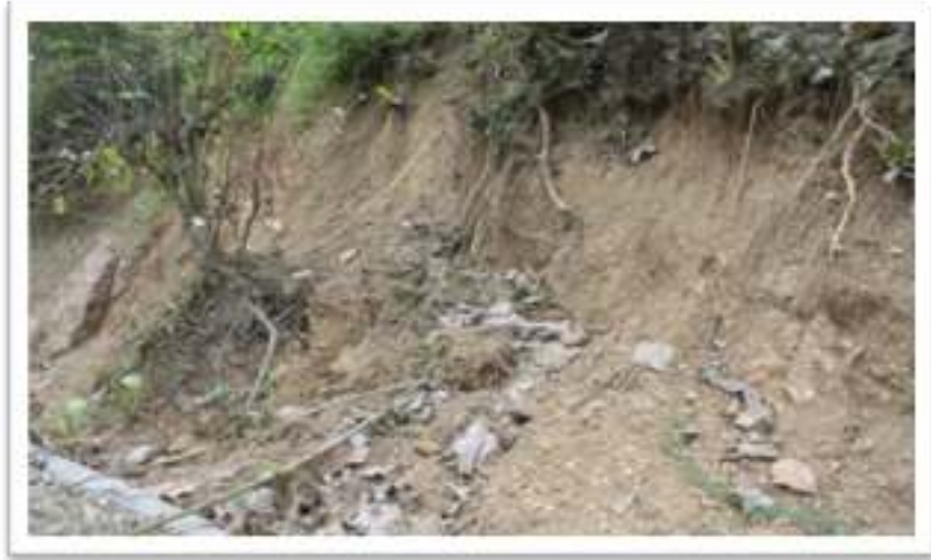
Gambar 46. Kondisi Longsoran di Desa Iloponu Kecamatan Tibawa Kabupaten Gorontalo
