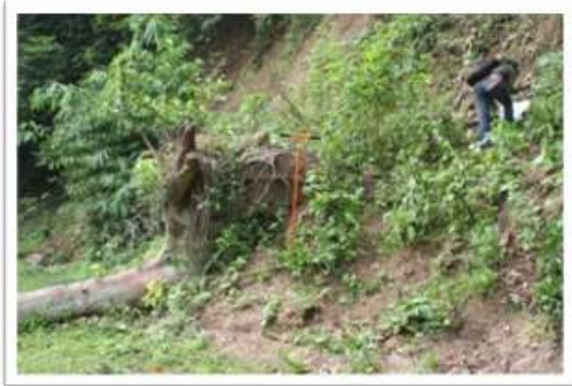
Gambar 35. Kenampakan Longsoran di Desa Alo Kecamatan Tibawa Kabupaten Gorontalo
