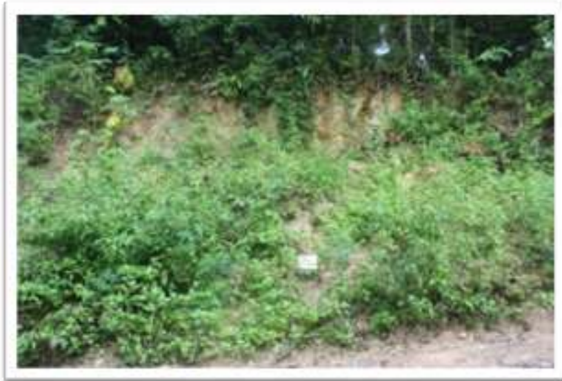
Gambar 41. Kondisi Longsoran pada Desa Isimu Utara Kecamatan Tibawa Kabupaten Gorontalo
