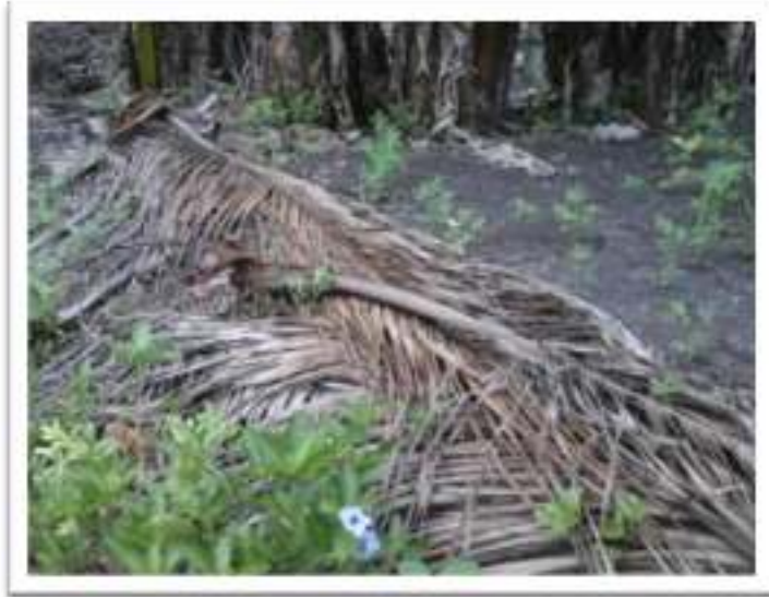
Gambar 73. Pemanfaatan daun kelapa sebagai penahan erosi tebing
