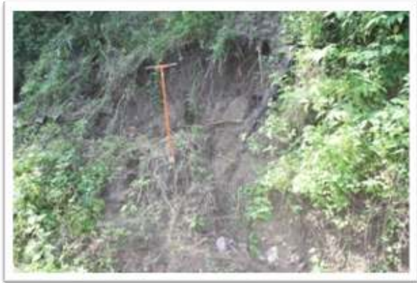
Gambar 40. Kondisi Longsoran pada Desa Molalahu Kecamatan Pulubala Kabupaten Gorontalo
