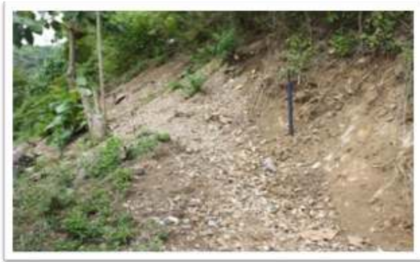
Gambar 47. Kondisi Longsoran di Desa Iloponu Kecamatan Tibawa Kabupaten Gorontalo
