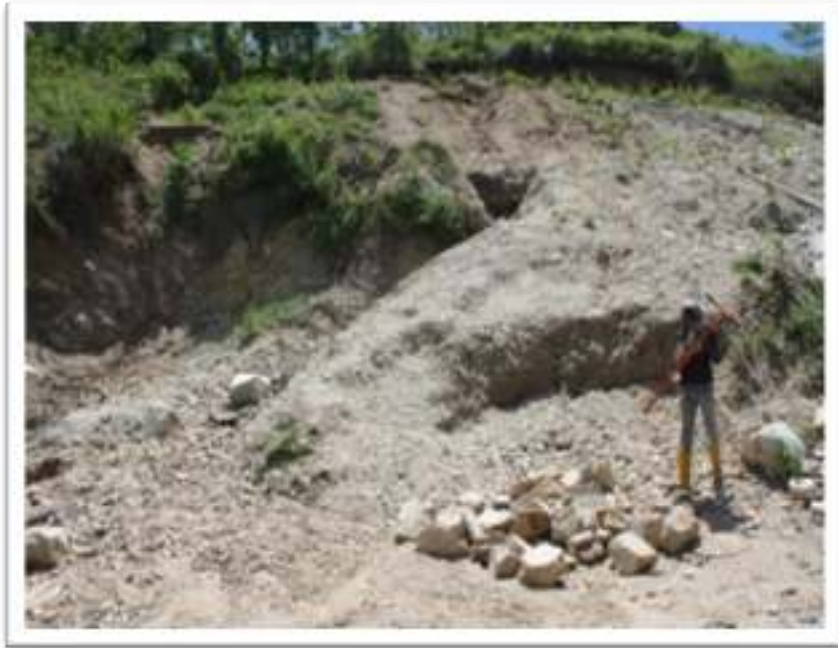
Gambar 38. Kondisi Longsoran di Desa Toyidito Kecamatan Pulubala Kabupaten Gorontalo
