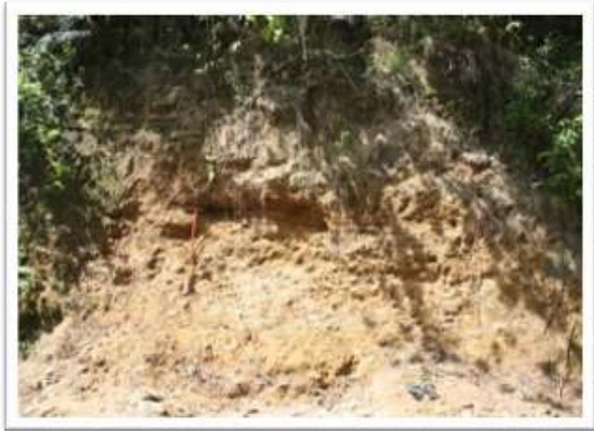
Gambar 39. Kondisi Longsoran di Desa Molalahu Kecamatan Pulubala Kabupaten Gorontalo
