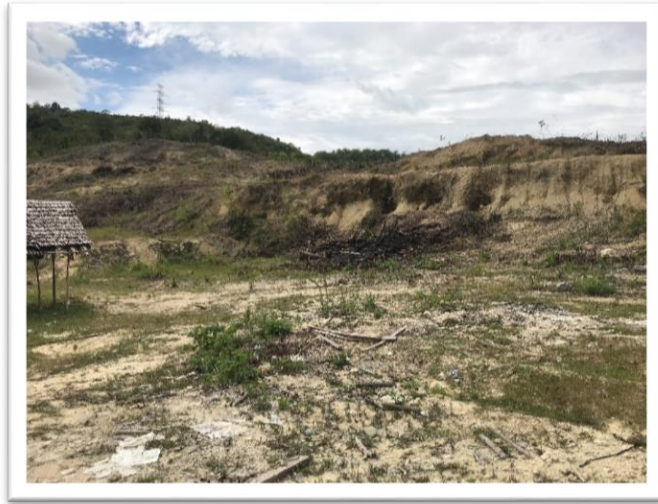
Lokasi tapak proyek pembangunan GI Donggala saat pemantauan April 2019
