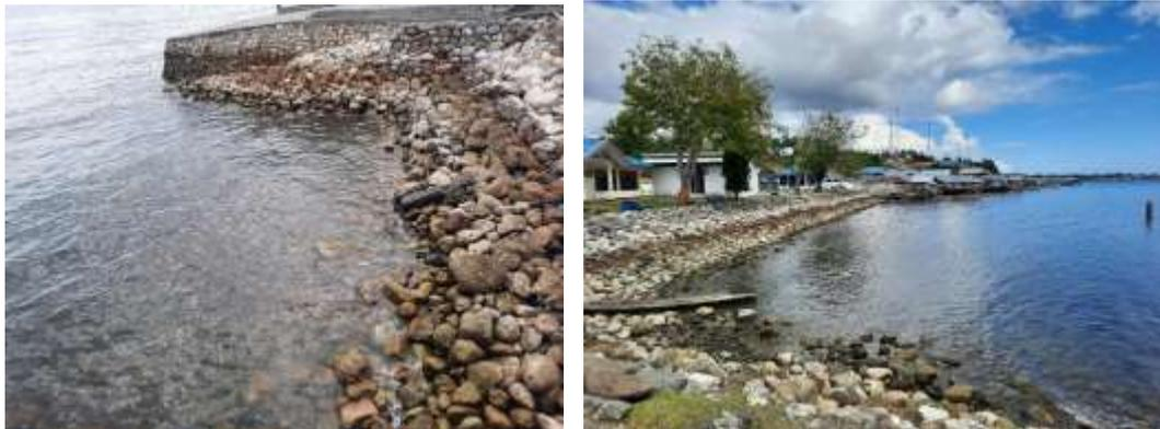
**Gambar 7.** Kondisi talud penahan ombak di sekitar Pelabuhan Pagimana
