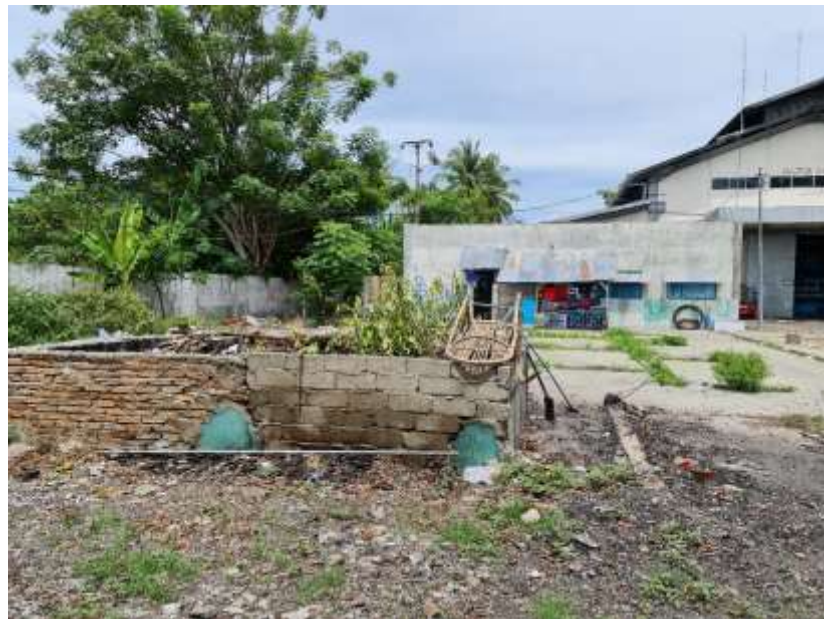
Kondisi tempat penampungan sampah domestic PLTD Marisa
