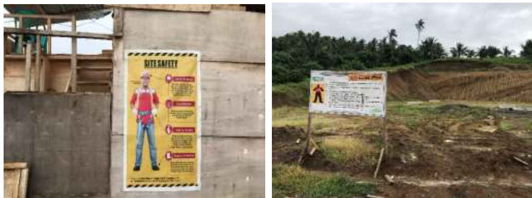
Gambar 12. Rambu-rambu K3 di lokasi pembangunan GI Tutuyan
