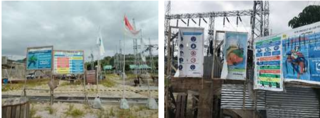
Gambar 9. Rambu-rambu K3 di lokasi pembangunan GI Likupang
