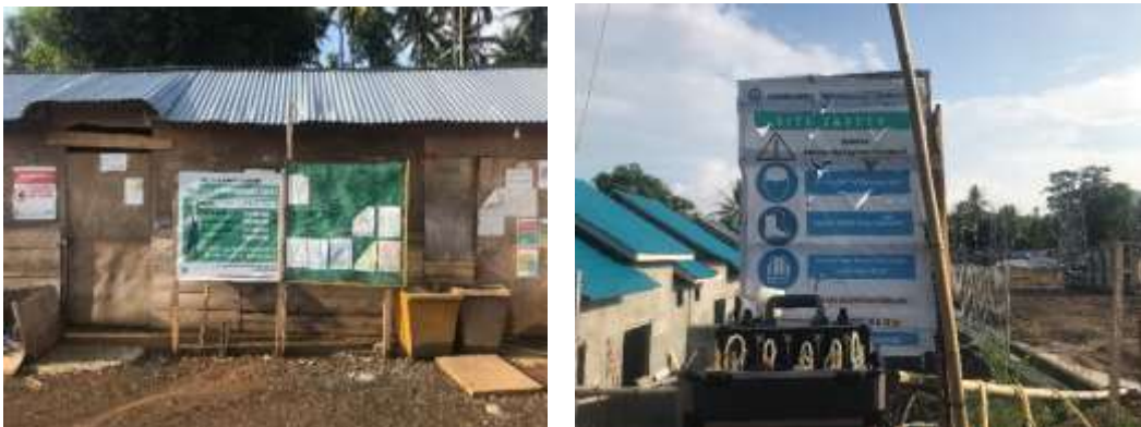
Gambar 10. Rambu-rambu K3 di lokasi pembangunan GI Pandu
