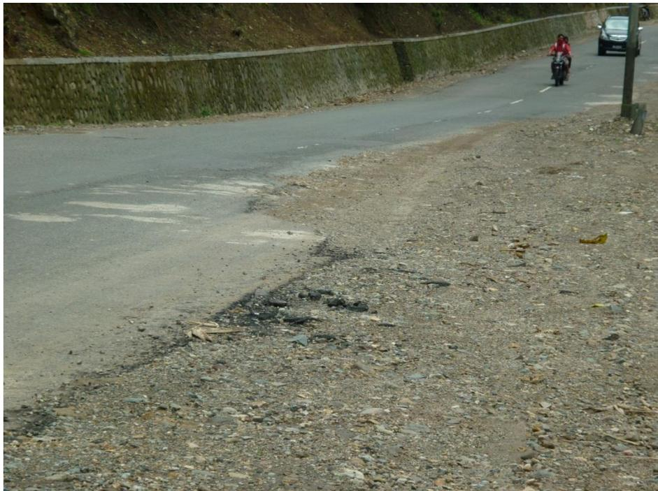
**Gambar 6 Setengah badan jalan yang sebelumnya mengalami longsor, dan saat ini sudah dilakukan perbaikan (Maret, 2012)**
