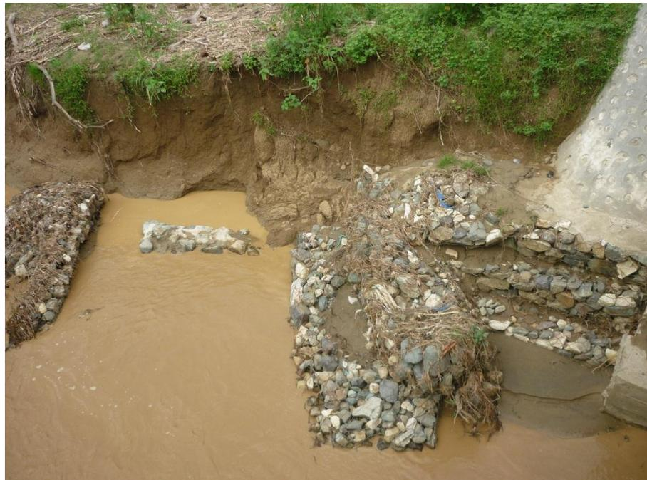
**Gambar 2 Lereng yang telah mengalami gerusan atau longsor (Nov, 2010)**
