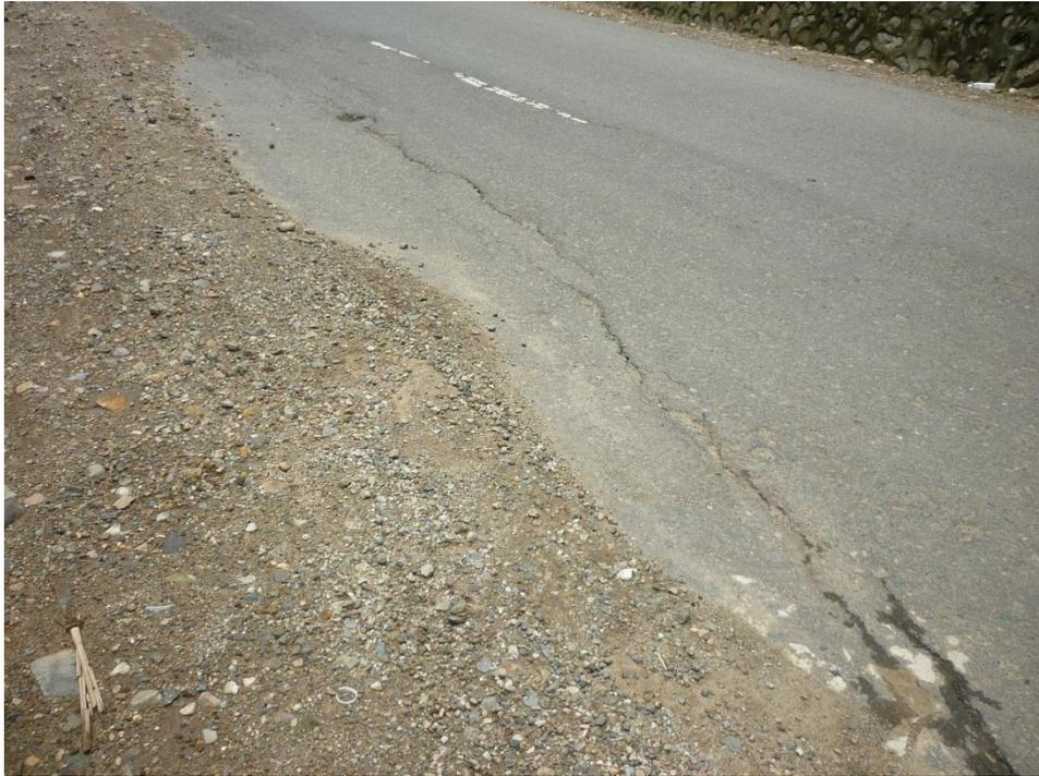
**Gambar 5 Retak memanjang pada jalan (Maret, 2012)**
