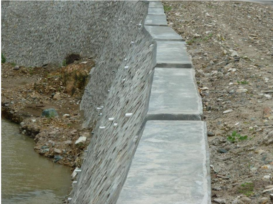
**Gambar 3 Perkuatan lereng dengan dinding penahan tanah, yang telah mengalami pergerakan akibat besarnya tekanan tanah aktif (Maret, 2012)**
