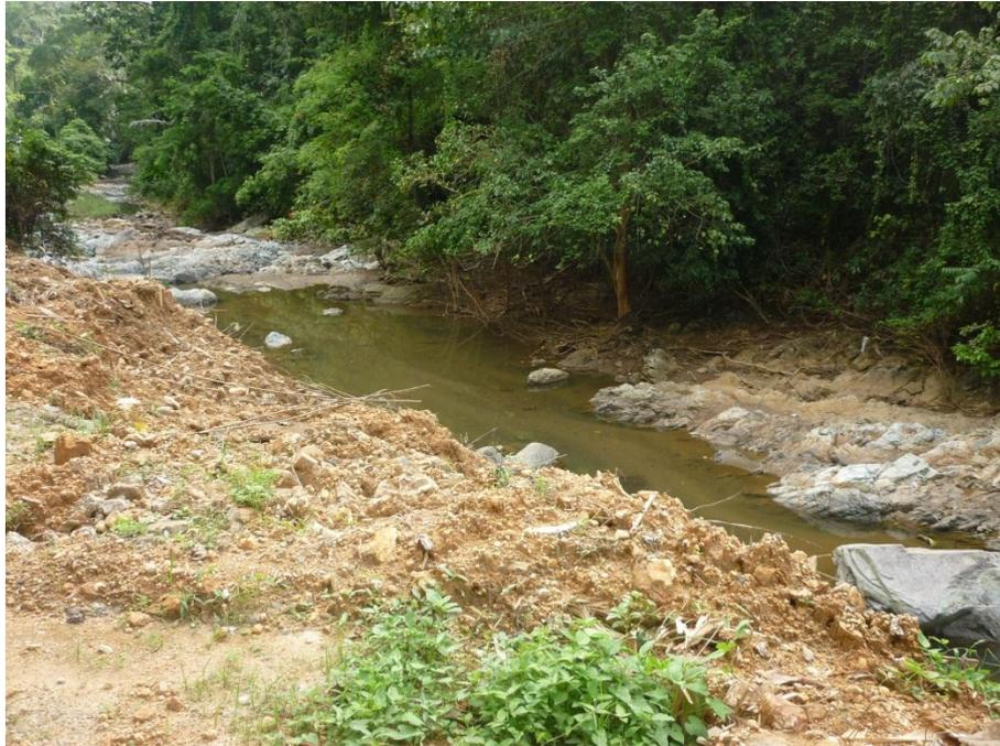
**Gambar 1 Lereng tanpa perkuatan yang berpotensi longsor (Nov, 2010)**
