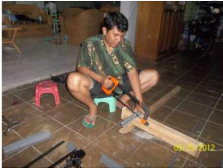
Gambar 15 : Proses Pemotongan Besi Siku Rak
