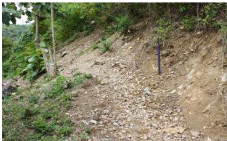
Gambar 5.29 Kondisi Longsor di Desa Iloponu Kecamatan Tibawa Kabupaten Gorontalo
