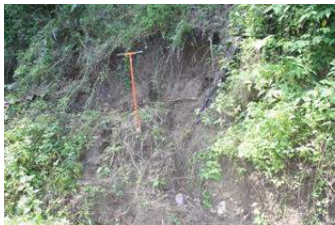
Gambar 5.22 Kondisi Longsor pada Desa Molalahu Kecamatan Pulubala Kabupaten Gorontalo
