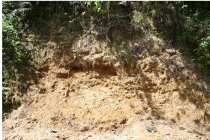
Gambar 5.21 Kondisi Longsor di Desa Molalahu Kecamatan Pulubala Kabupaten Gorontalo
