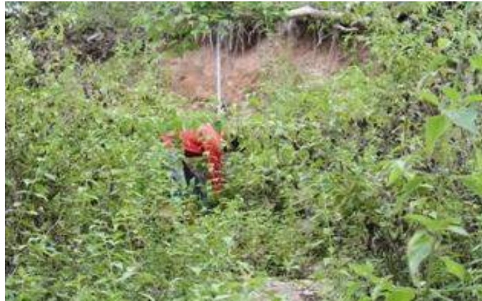
Gambar 5.31 Kondisi Longsoran di Desa Toyidito Kecamatan Pulubala Kabupaten Gorontalo
