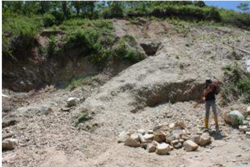
Gambar 5.20 Kondisi Longsoran di Desa Toyidito Kecamatan Pulubala Kabupaten Gorontalo
