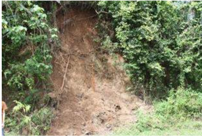
Gambar 5.19 Kondisi Longsoran di Desa Labanu Kecamatan Tibawa Kabupaten Gorontalo
