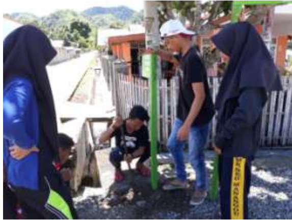
Gambar 4. Pemasangan jalur evakuasi
